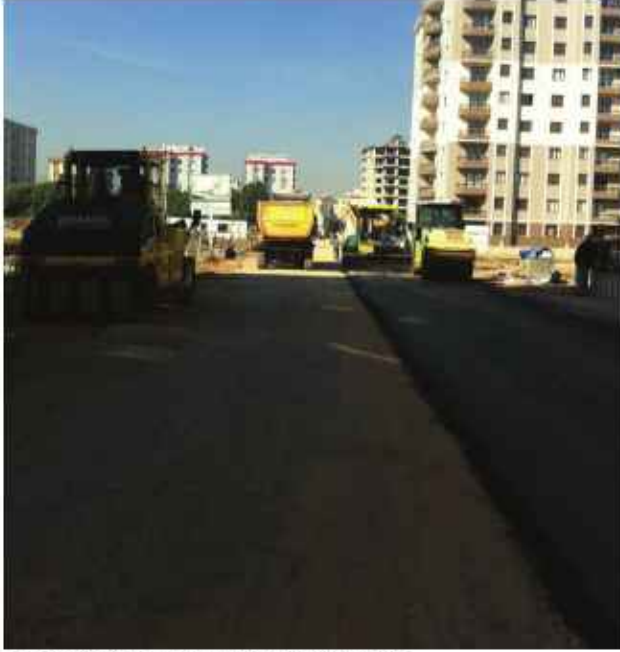
271 SOKAK ASFALTAMA ÇALIŞMALARI
