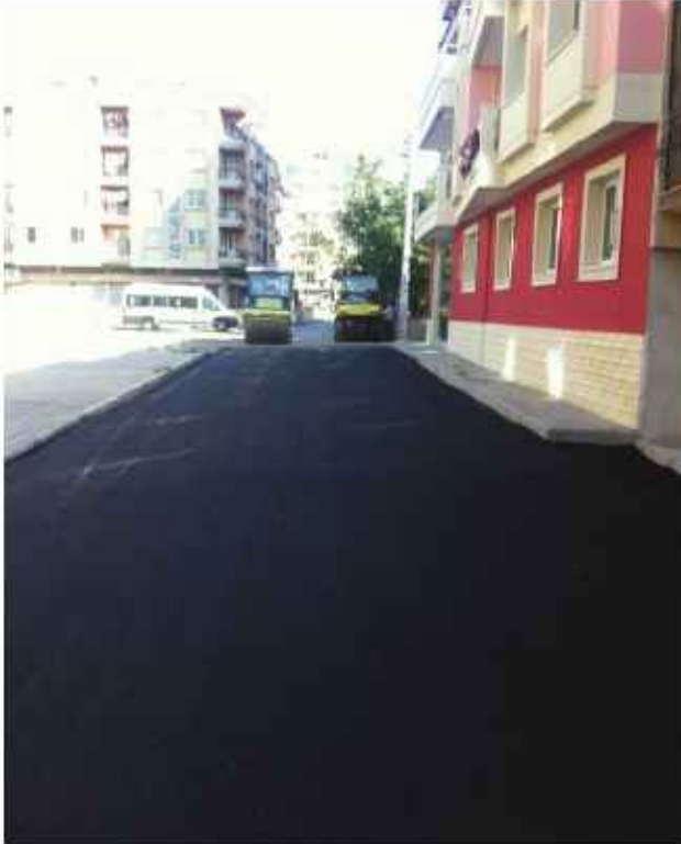
544 SOKAK ASFALTAMA ÇALIŞMALARI
