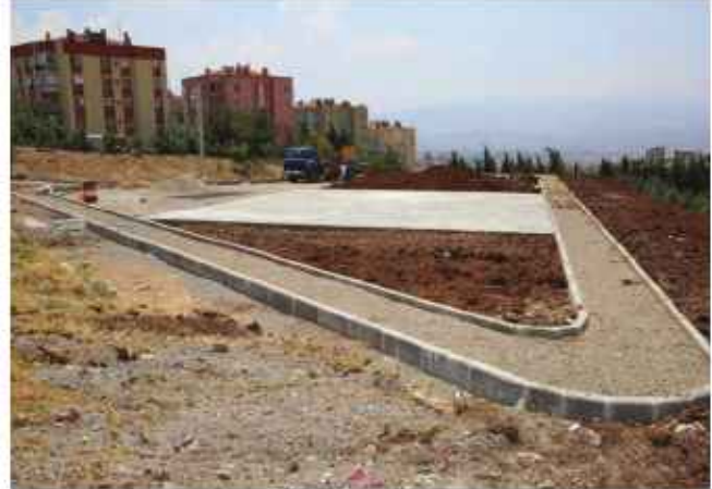
İZKENT MAHALLESİ DENİZ GÖREN PARK YAPIM AŞAMASI
